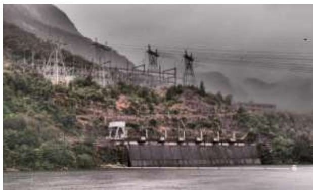
(マウナポリ変電所)
